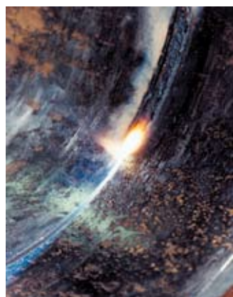
尺寸为8英寸X375英寸的API 5L-X52管道内侧，以5G位置进行焊接。
